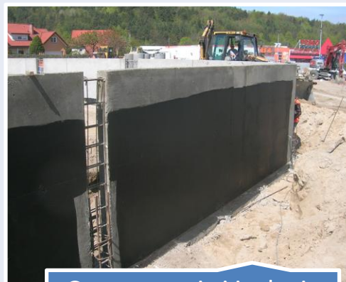
Gruntowanie i izolacja przeciwwilgociowa
